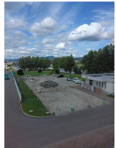
令和5年8月28日より、校舎増築工事が始まりました
